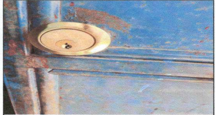
Foto 2: 4,1 puertas de metal: 4,2 Sustitución de chapas.
